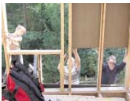
Her tettes veggene med asfaltplater.
